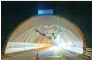
2023.01. 광주원주고속도로 터널 조명 ESCO 개선사업 공사 수주
