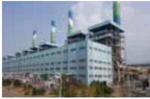
2023.07. 현대그린파워 1~8호기 터빈 보일러설비 경상정비공사 계전분야 수주
