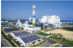
2023.03. GS동해전력 1,2호기 환경설비 경상정비공사 및 운전 용역 개시
